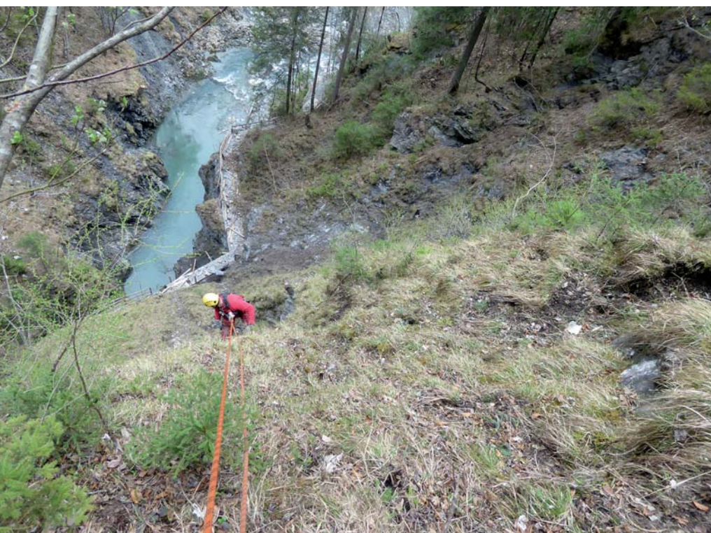
Die Felsräumarbeiten mussten zum Teil unter schwierigsten Bedingungen ausgeführt werden.
